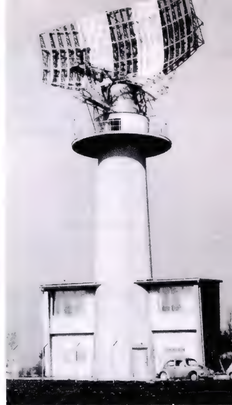
Bild 2. 14,5 Meter breit und 7 Meter hoch ist die riesige Antenne der Mittelbereichs-Radaranlage, die z. Z. auf dem Flughafen München-Riem aufgebaut wird
